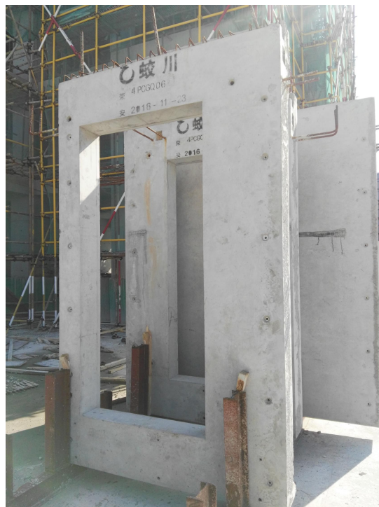
荣安心尚园项目现场使用的预制混凝土构件
